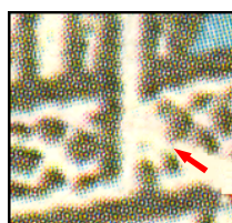
MiNr 2381 I Bruch der Balustrade am rechten Turm, Feld 9
