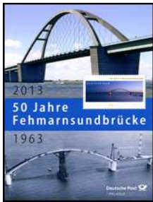
50 Jahre Fehmarnsundbrücke MiNr EB Bd-EB 3/2013 7,40 €
